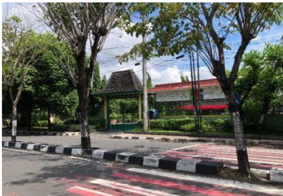
Gambar 5. Kondisi perlengkapan jalan ZoSS di SMP Negeri 14 Yogyakarta
