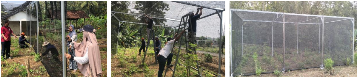
Gambar 1. Membangun Struktur Rumah Paranet
