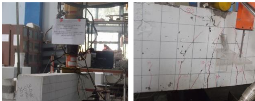
Gambar 15. Retak awal pada balok 3D16 Normal
