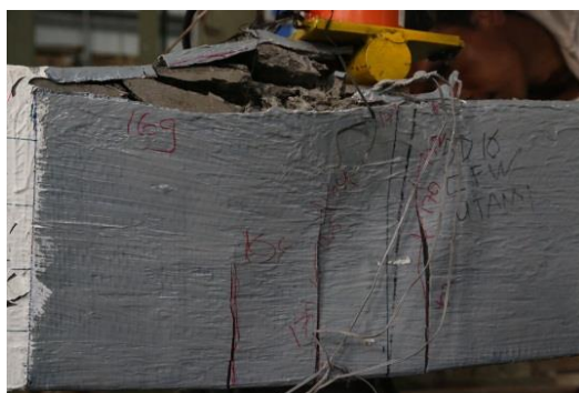
Gambar 23. Retak pertama yang terjadi pada balok 5D16 CFRP
