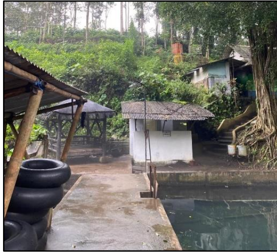
Gambar 4. Fasilitas toilet di Sumber Jenon
