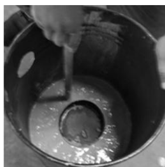
Gambar 7. Pemasangan semen castable di dasar tungku
