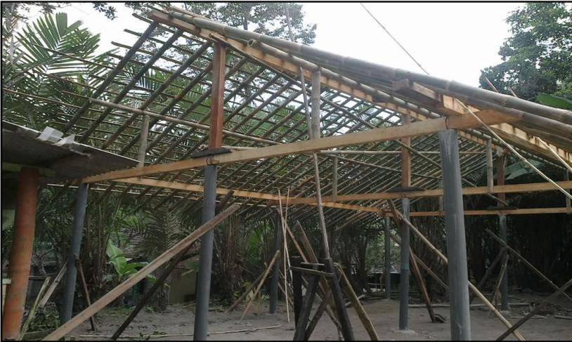
**Gambar 2. Kerangka Rumah Jamur dengan Rangka Kayu, Tiang Pralon Dicor Semen**
