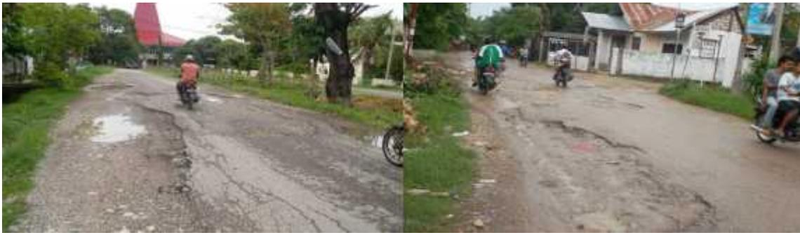
Gambar 13. Kerusakkan Pinggir Perkerasan
