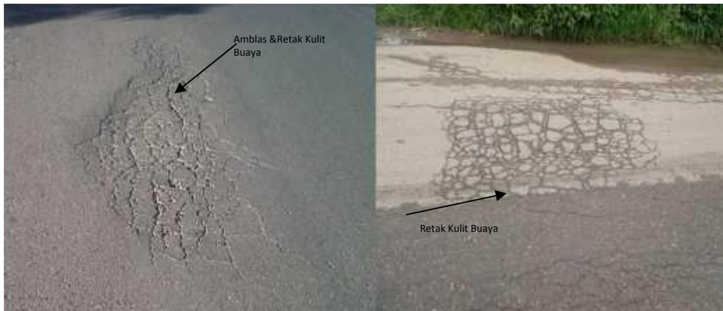
Gambar 9. Deformasi dengan tipe kerusakan Retak Kulit Buaya
