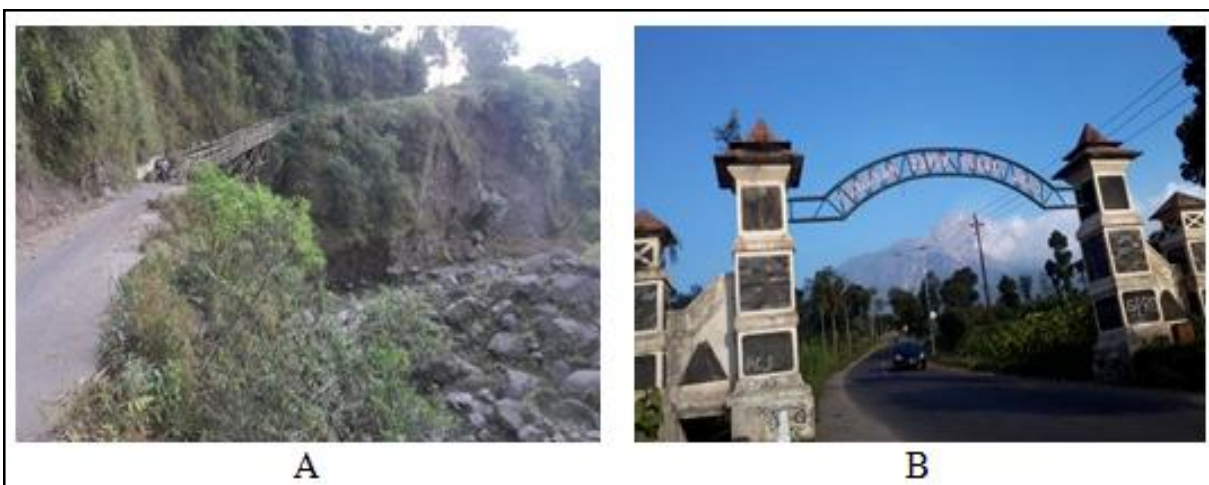
Gambar 3. A = Kerusakan Infrastruktur Jalan oleh Aliran Lahar di Sempadan Sungai Pabelan Desa Jrahah, Kecamatan Selo. B = Wilayah Sekitar Perbatasan Kecamatan Selo-Kecamatan Sawangan dengan Tingkat Kerusakan Rendah oleh karena Pengaruh Faktor Relief Kaki Gunungapi Merbabu
