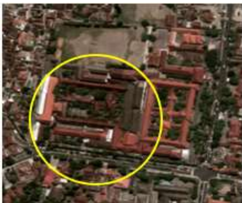
Gambar 2. Situasi Eksisting Bangunan
