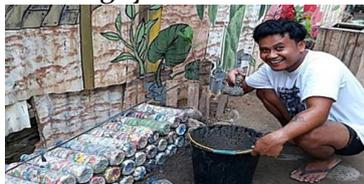
Gambar 3. Proses pembuatan bangku dari botol *ecobrick*
