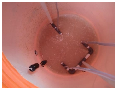
Gambar 3. Instalasi Sistem Aerasi
