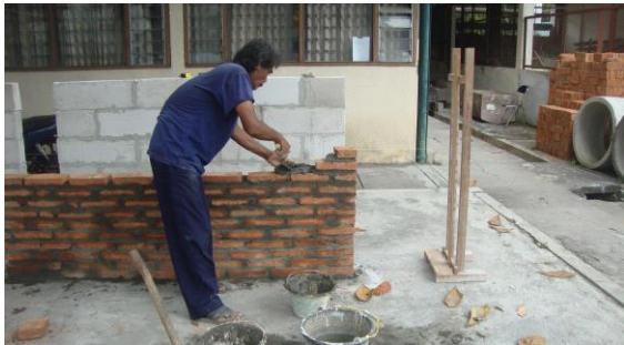
Gambar 5. Pekerjaan Pasangan Batu Bata Merah
