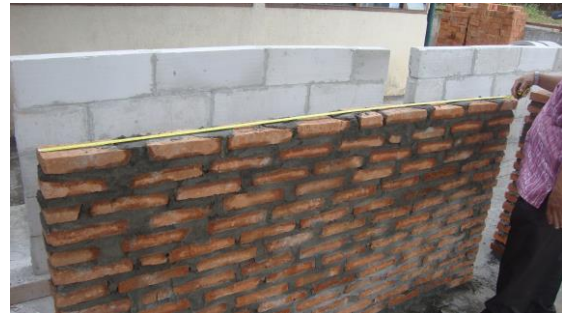
Gambar 6. Pekerjaan Pasangan Batu Bata Merah
