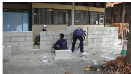
Gambar 9. Pekerjaan Pasangan Bata Ringan
