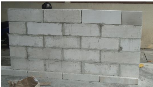
Gambar 8. Pekerjaan Pasangan Bata Ringan
