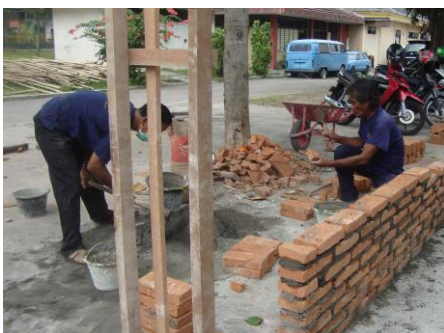
Gambar 4. Pekerjaan Pasangan Bata Merah
