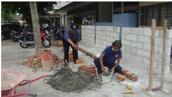
Gambar 10. Pekerjaan Pasangan Bata Ringan
