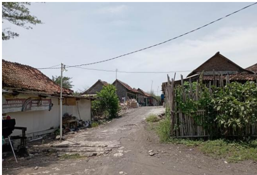
Gambar 3 Kondisi jalan lingkungan yang tidak memiliki saluran drainase (Sumber : Dokumentasi Peneliti, 2022)
