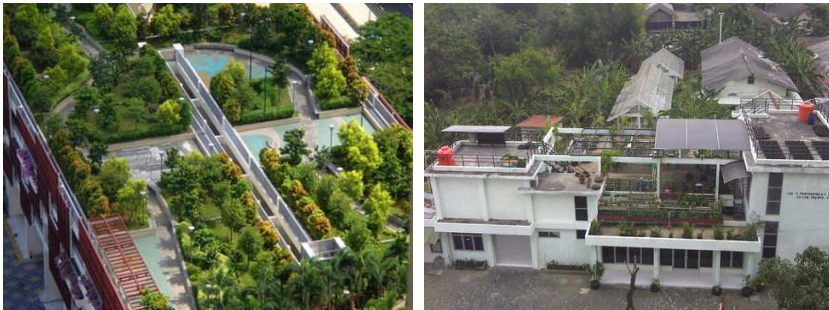
Penanaman vegetasi di atap bangunan
