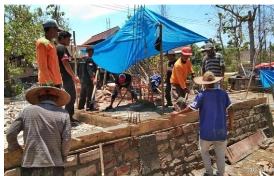
Gambar 3. Gotong royong warga memperbaiki rumah penghuni sempadan sungai yang terkena banjir
