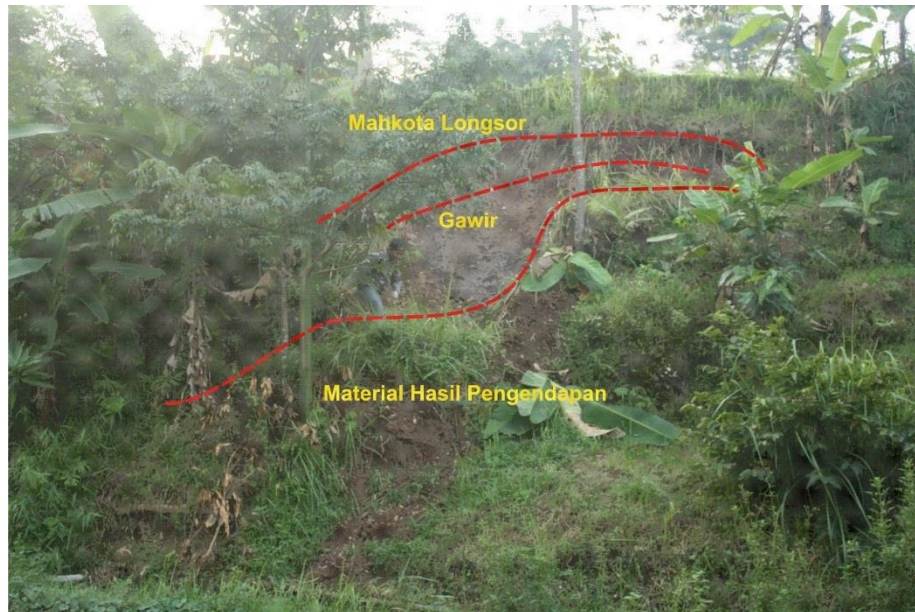
Gambar 1. Longsor pada perbukitan terkikis dengan lereng agak curam.
