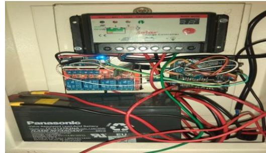
Gambar 4.7 Instalasi Modul Solar Charge Controller Pada Box Panel
