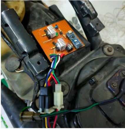
Gambar 10. Pemasangan Soket ECU
