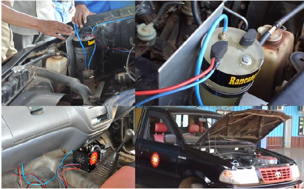
Gambar 7. Proses pemasangan generator pada Mobil Uji
